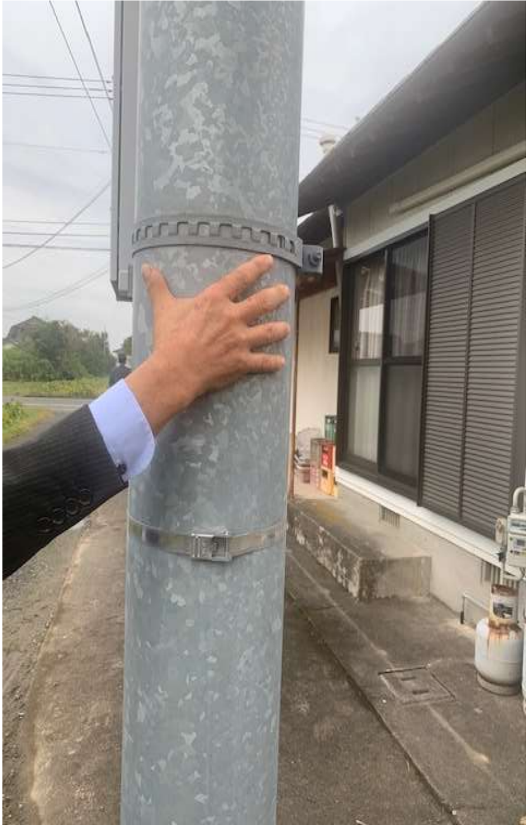
既設の子局建柱の太さ
