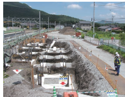
中軽駅南口自由通路基礎工事
