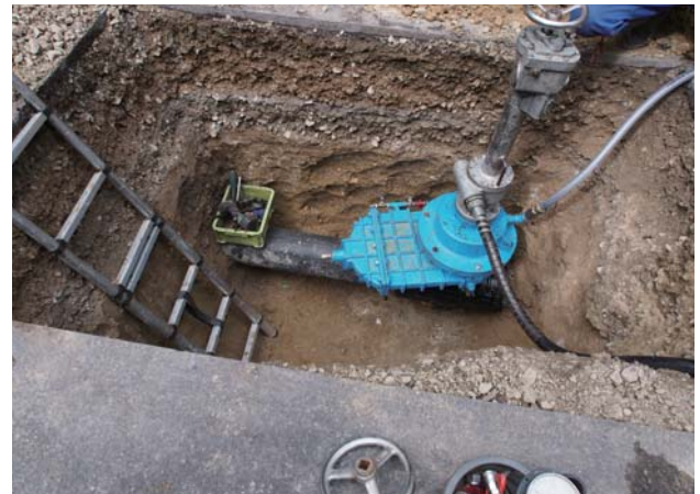
交換作業のすすむ石綿管
