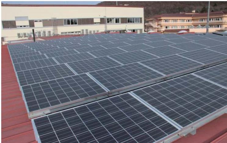
庁舎屋根に設置された年間約 35,000kwh のソーラーパネル
