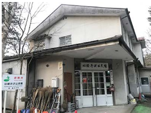
昭和27年建築の旧軽井沢病院跡舎を使用している旧軽井沢公民館
