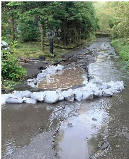
災害時に活躍する土のう
