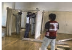
避難所運営支援(パーテーション組立) (福島県本宮市)
